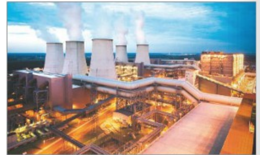
5 Centrale thermique au lignite, en Allemagne.
